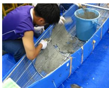
生コンクリート打設
